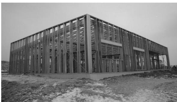
Рис. 2.7. Несущий каркас коммерческого здания из легких стальных тонкостенных конструкций
