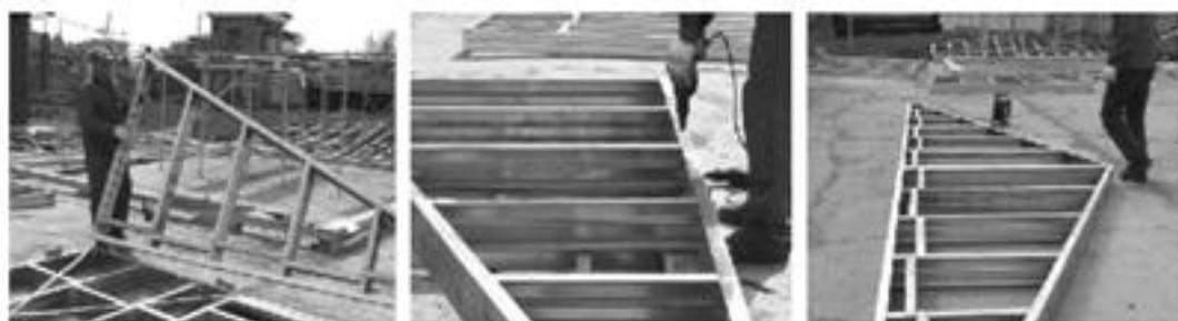
Рис. П.8.11. Сборка фронтовой 9-ти метровой фермы
