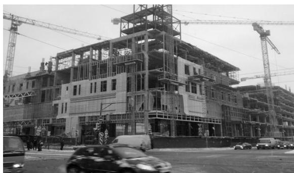
Рис. 2.8. Навесной каркас ограждающих конструкций из термопрофилей ТС на многоэтажном железобетонном здании
