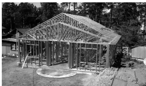
Рис. 2.6. Несущий каркас коттеджа из легких стальных тонкостенных конструкций
