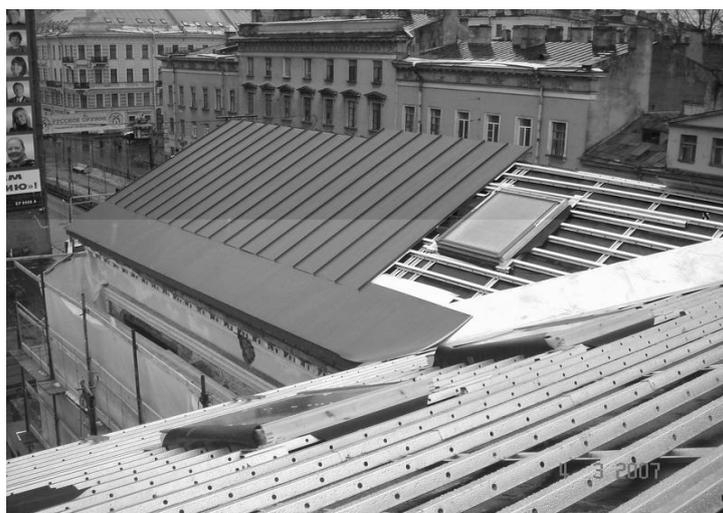
Рис. 7.19. Устройство кровельного покрытия мансарды
