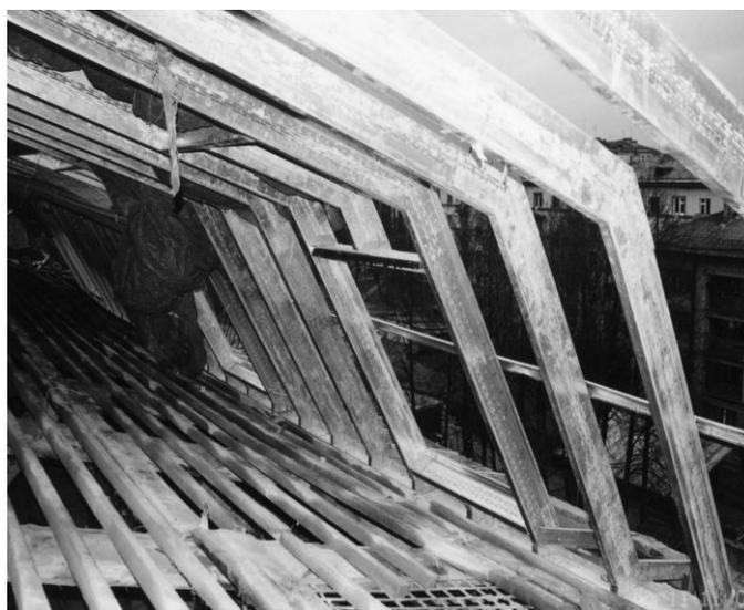
Рис. 7.17. Конструкция несущей поперечной рамы мансарды
