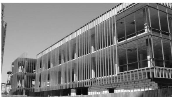
Рис. 2.5. Навесной каркас ограждающих конструкций из термопрофилей ТС
