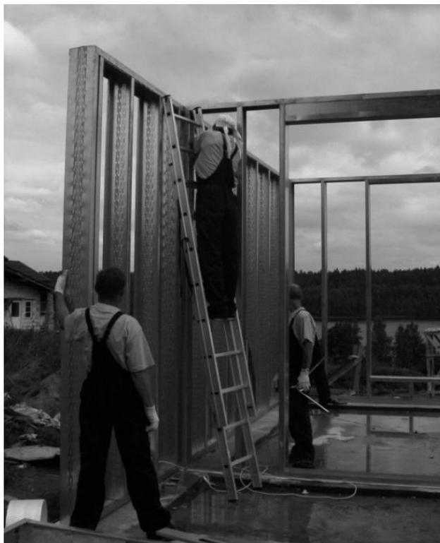
Рис. 7.34. Производство монтажных работ ЛСТК на месте
