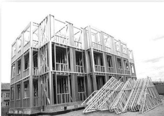
Рис. 7.1. Пример многоквартирного малоэтажного (до 4-х этажей) здания из ЛСТК с несущим каркасом из тонких гнутых профилей
