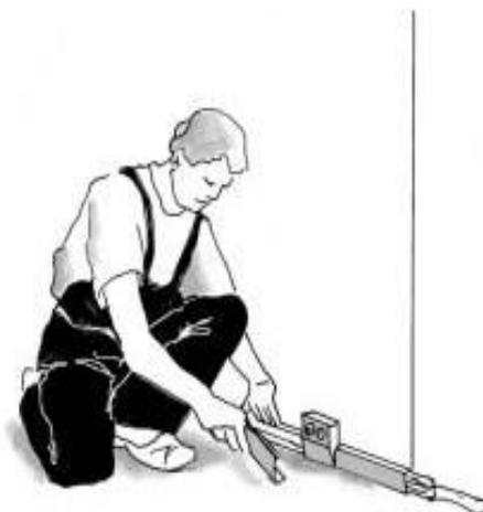
Рис. 7.26. Вариант размещения электропроводки за плинтусом
