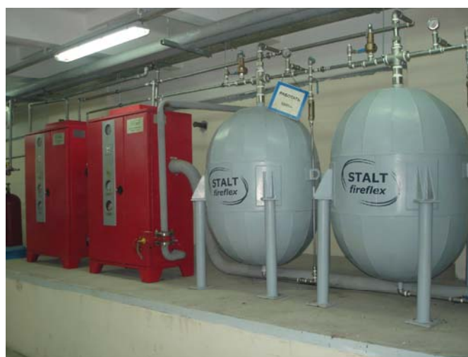
Рис. 4. СПГТ «STALT-FireFlex», размещенная на СШГЭС
