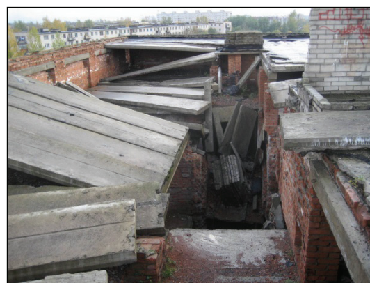
Рисунок 7. Обрушение плит покрытия из-за потери несущей способности размороженной кладки внутренних стен недостроенного здания
