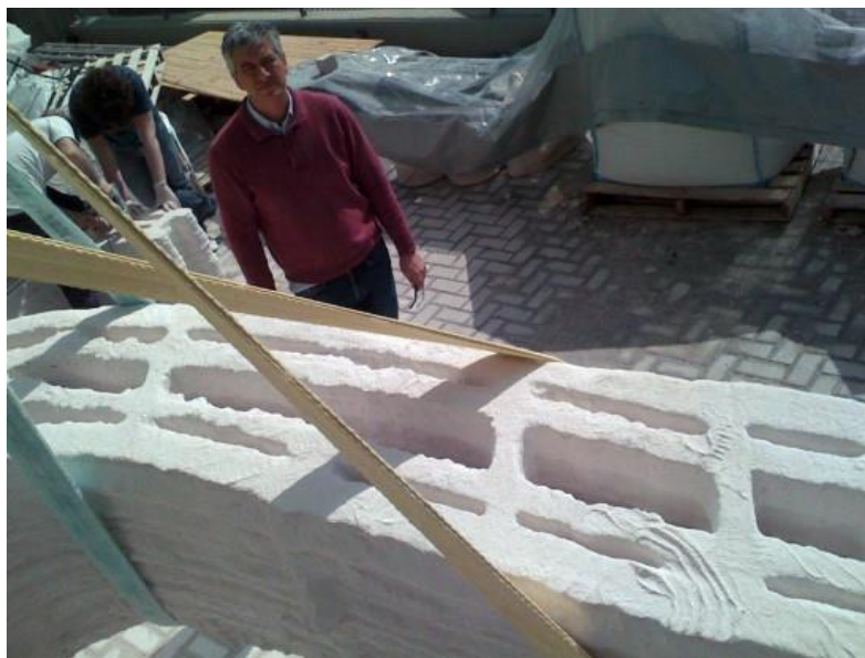
Рис. 4. Принтер итальянского инженера Enrico Dini для «печати» фрагментов зданий (технология Inkjet). Строительный материал – песок и неорганическое связующее
