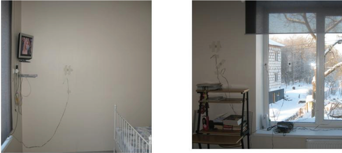
Рисунок 4. Расположение датчиков температуры на внутренней поверхности стены
