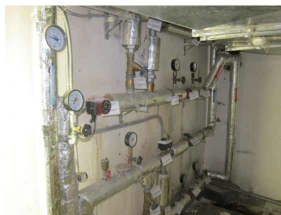
Рисунок 2. Приборы контроля работоспособности калорифера (термометры, манометры)
