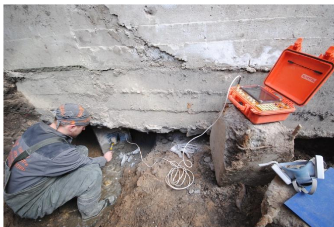
Рисунок 3. Измерение длины сваи акустическим методом с установкой датчика в штрабу
