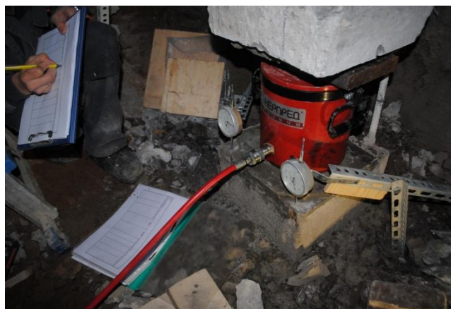
Рисунок 6. Испытательное оборудование на свае в шурфе №21
