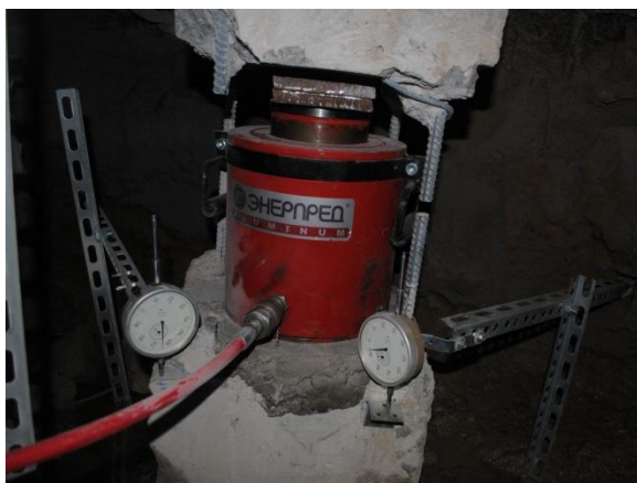
Рисунок 5. Испытательное оборудование на свае в шурфе №20
