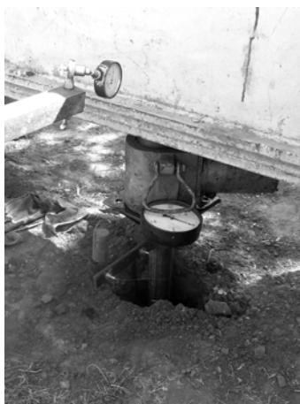
Рис. 7. Проведение испытаний сваи статическими сжимающими нагрузками
