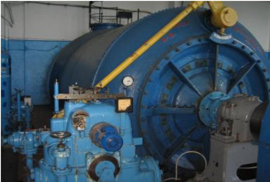
Рис.4. Система управления гидроагрегатом №3 Кондопожской ГЭС до модернизации (гидромеханический привод)
