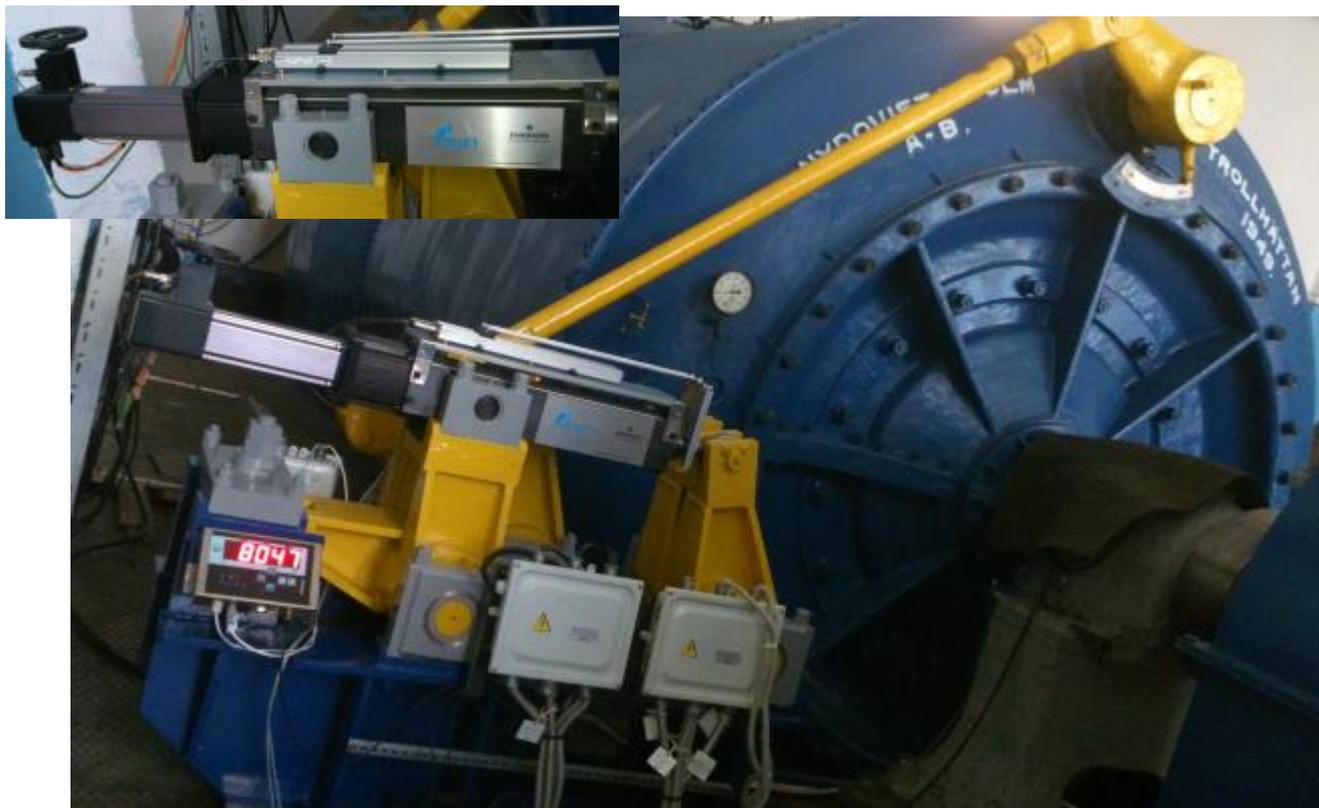
Рис.5. Система управления гидроагрегатом №3 Кондопожской ГЭС после модернизации (электрический привод)
