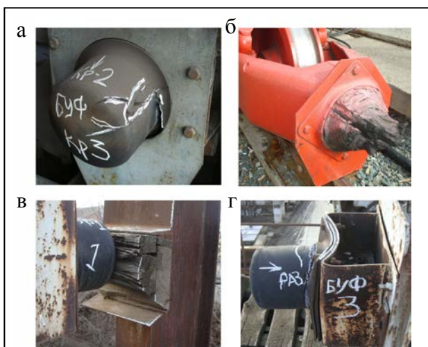
Рис.2. Повреждения возникающие в результате ударных взаимодействий г/п кранов с ТУП: а - разрушение резинового буфера мостового крана; б – разрушение резинового буфера порталного крана; в- разрушение ударного ТУП; г-деформация м/к мостового крана в месте установки буферного устройства
