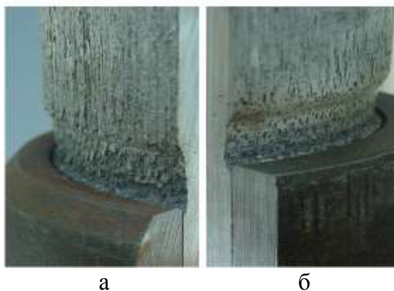
Рис. 3. Наружные поверхности буровой трубы из сплава 1953Т1 вблизи замкового соединения после эксплуатации 1000 ч при 45 °С: а – у ниппеля; б – у муфты
