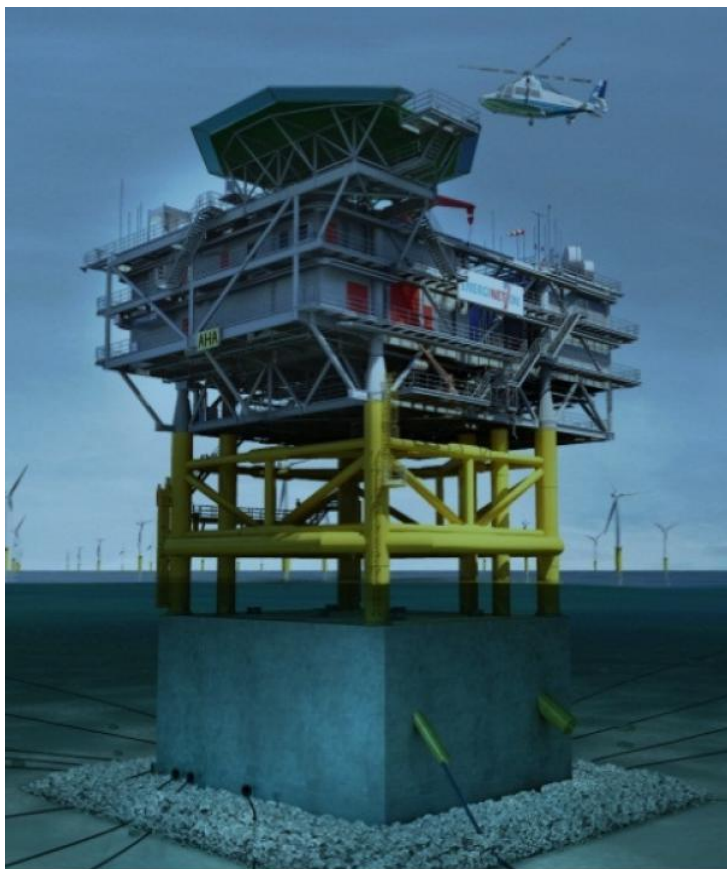
Рисунок 3. Проект сооружения с защитой из каменной наброски [24]
