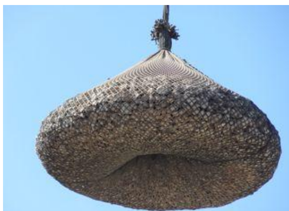
Рисунок 4. Защита с помощью сеток с камнями фирмы Куоуа Со Ltd [25]: а – вид сетки; б – схема укладки сеток на участке местного размыва у края сооружения
