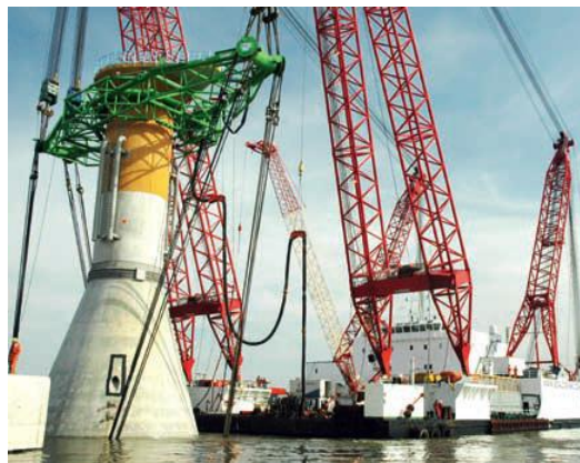
Рисунок 11. Конусообразная форма опорного основания [30]
