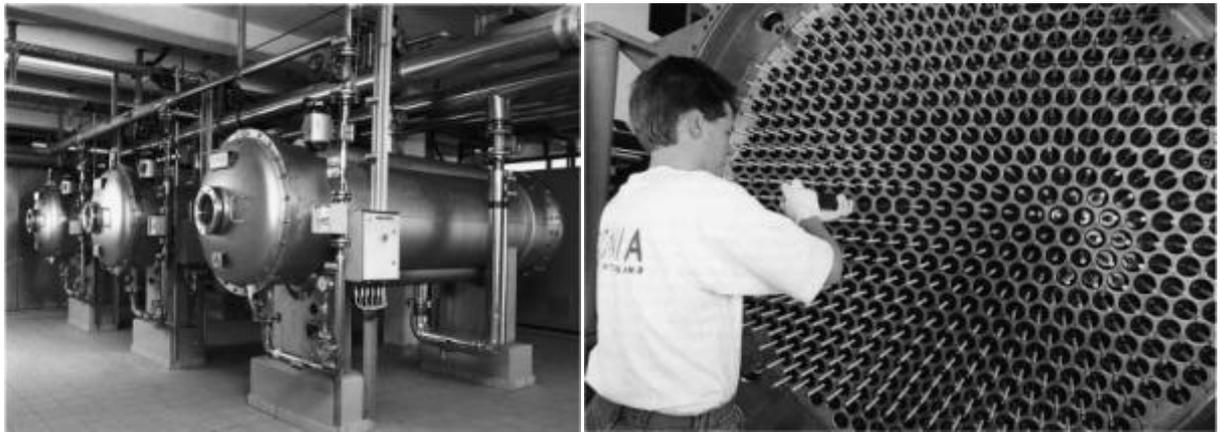
Рис. 1.10 – Фотография промышленного генератора озона (Ozonía Ltd.) [95]
