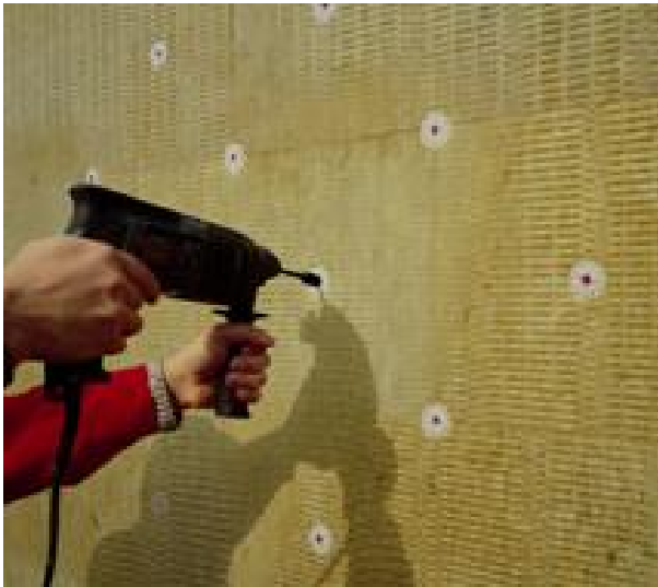
Механическое закрепление минеральной ваты
