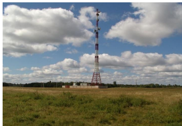
Рисунок 2.6. Промежуточные радиорелейные станции (ПРС). Линейные потребители МГ ООО «Газпром трансгаз Петербург»
