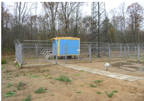
Рисунок 2.5. Контролируемые пункты телемеханики (КПТМ)
