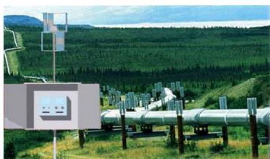
Рисунок П.1.42. Мониторинг газопроводов
