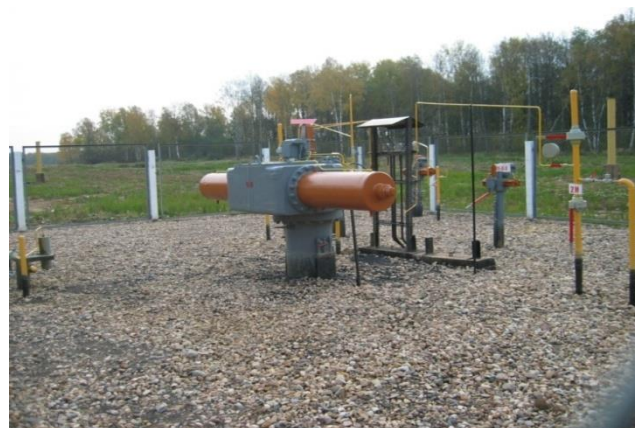
Рисунок 2.4. Крановые узлы магистральных газопроводов
