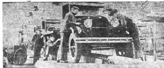
Главный конвейер Нижегородского авто-сборочного
