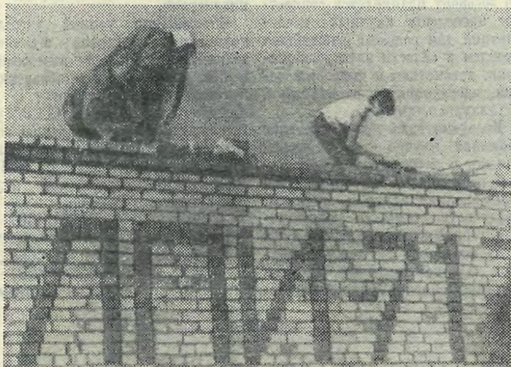
Отряд «Термиты». На строительстве фермы.
