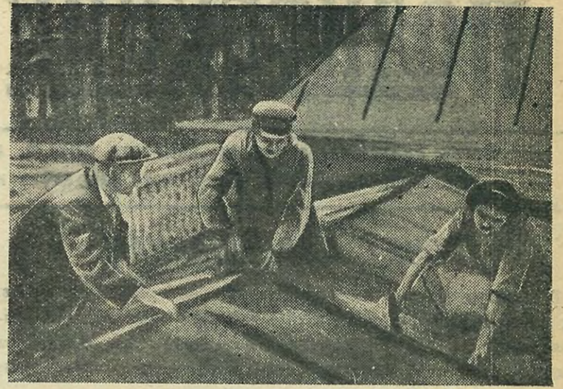
На восстановлении родного города — ремонт крыши
