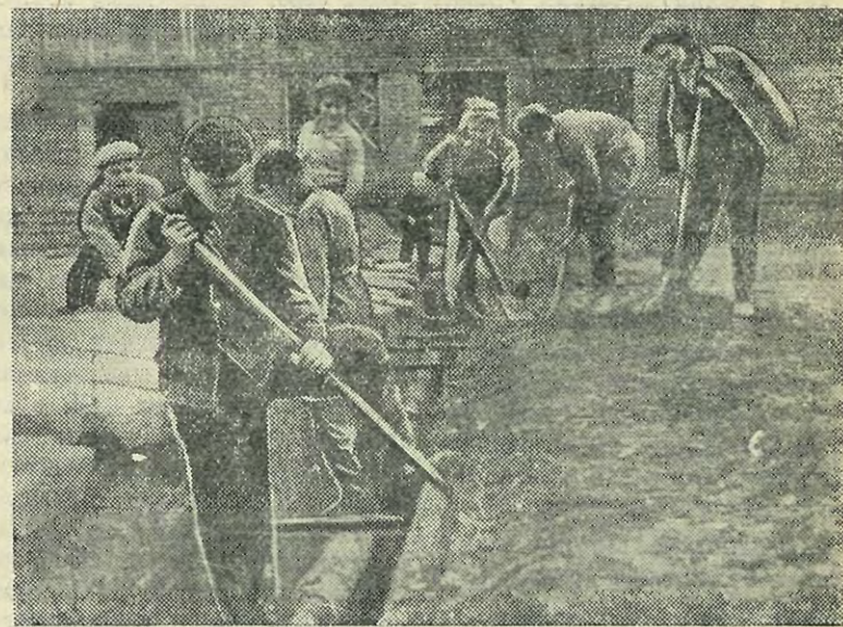
Бригада студента Катюка начала восстановление отопительной системы аспирантского дома.
