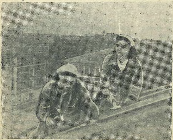
Ремонт кровли. На снимке: студентка Абясова (справа) и студентка Коптевская за работой.
