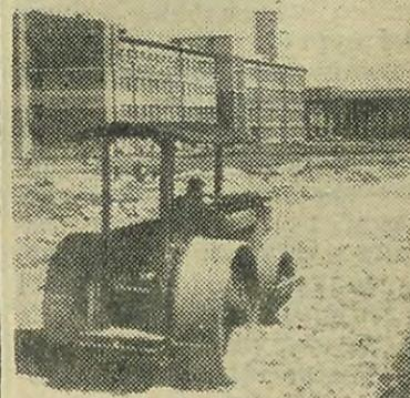
Укатка новой дороги, соединяющей гл. здание с гидрокорпусом и высоковольтной лабораторией
