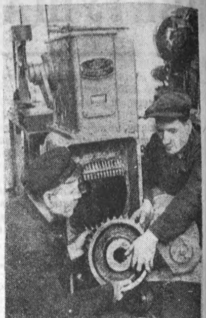
На заводе „Электроаппарат“ в экспериментальной мастерской заканчивается сборка инерционного привода для канала „Волга—Москва“. Этот привод освоен в СССР впервые
