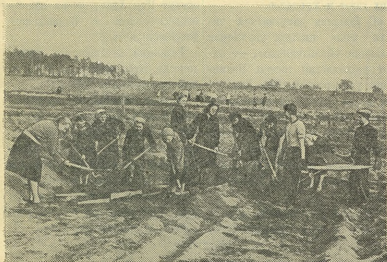
На снимке: студенты 272-й группы на строительстве стадиона. Фото студента Э. Скурлатова
