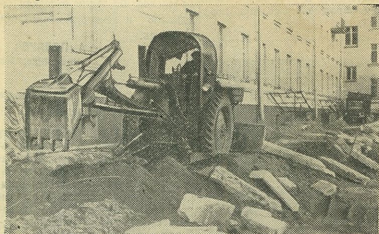
Бульдозер принялся утюжить площадку, экскаватор готовил канаву...
