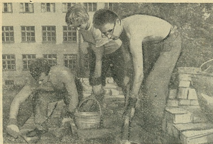
На снимке: бригада Ю. Селянина за кладкой стены лаборатории гидротехнических сооружений.
