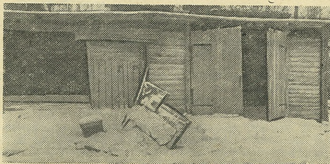
Здесь «хранятся» строительные материалы.
