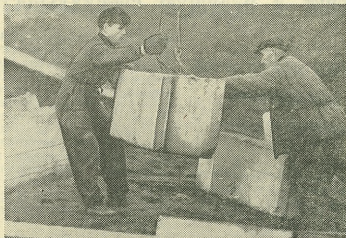
НА СНИМКАХ (слева направо): рабочие УНР-42 Николай КАЛАЧЕВ, председатель комсомольского штаба и ветеран-строитель Г. З. ЖИТКОВ за укладкой бетонных блоков.
