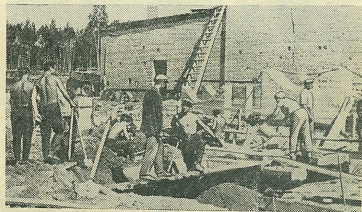
Девятая бригада (студентов) на строительстве фундамента одного из цехов Новгородского химического комбината.
