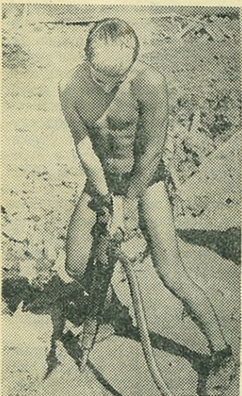
За любую работу приходилось браться студентам на стройке большой химии. На снимке: бригадир 9-й бригады В. Коркин во время работы с отбойным молотком.
