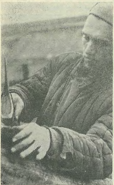
В. Петров скрепляет стропила.
