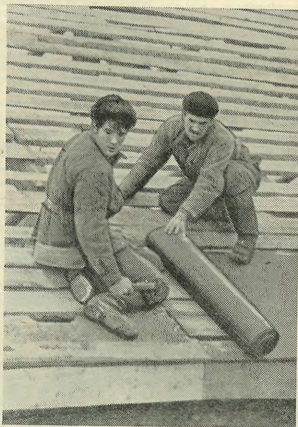
На заполярной целине. Студенты С. Сидоров (слева) и Л. Ярославцев покрывают толем крышу школы-интерната, построенной в пос. Шуга.
