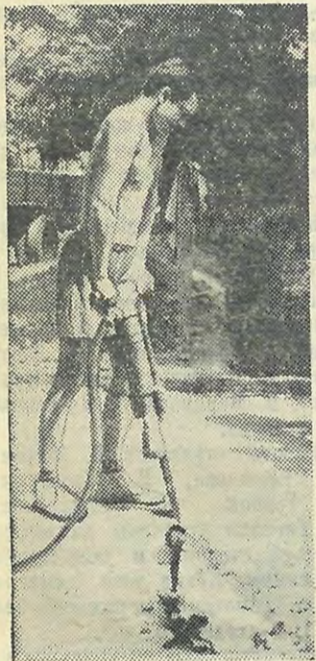
Николай Третьяк прокладывает трассу будущей канавы.
