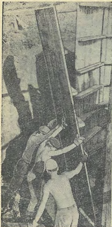
Еще усилие — и последний щит внутренней опалубки резервуара встанет на свое место.
