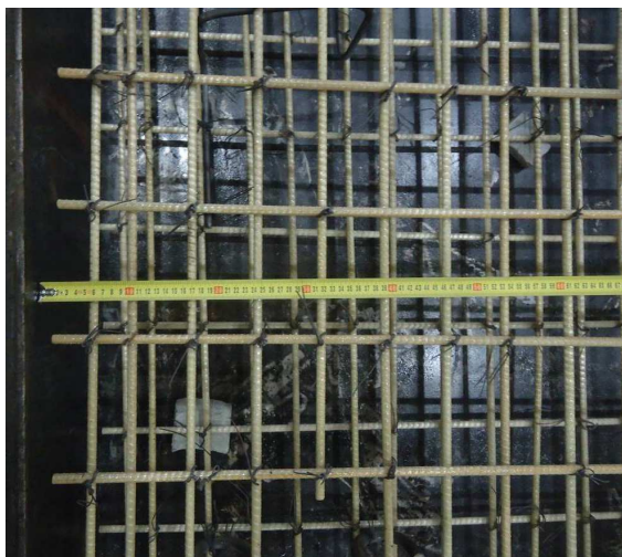
Рисунок 1. Армирование фундаментной плиты ПЦ-80
