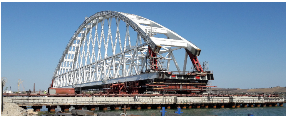
Рис. 10. Пролетное арочное строение на выкаточном пирсе перед началом погрузки на плавучие опоры 26 августа 2017 г. (фото АО «ЦКБ «Коралл»»)
