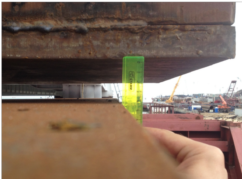
Рис. 14. Размах качки при установке автодорожного пролетного строения (менее 5 см). Высота волнения около 0,3 м (9 октября 2017 г., фото АО «ЦКБ «Коралл»»)
