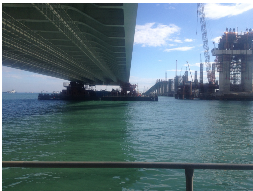
Рис. 12. Позиционирование и заведение плавучей системы с автодорожным пролетным арочным строением в створ моста с помощью системы позиционирования (11 октября 2017 г., фото АО «ЦКБ «Коралл»»)
