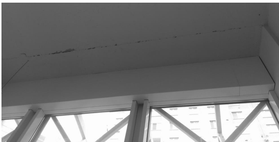
Рис. 1. Фрагмент внутренней стороны наружной стены фасада
