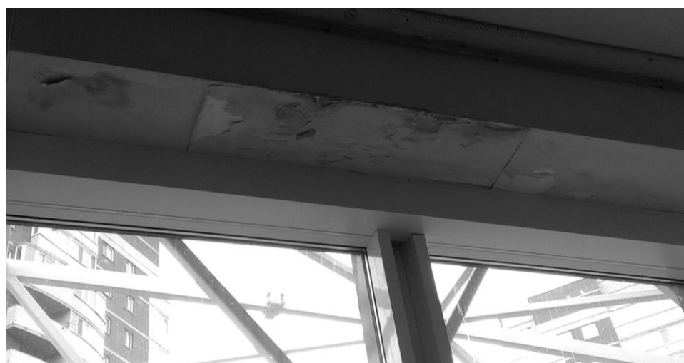
Рис. 2. Фрагмент балки покрытия
