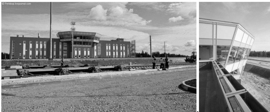
Рис. 1. Фасад здания ГАЦ и выступающий стеклянный эркер
