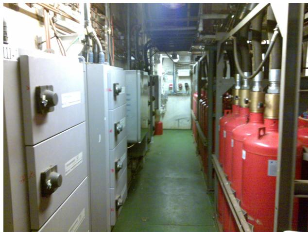
Рис. 1. Система газового пожаротушения и флегматизации (СГПиФ).
