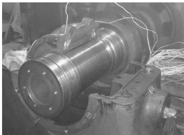
Рисунок 7 – Монтаж нижней половины вкладыша подшипника из углепластика УПФС в турбину АР-6 ТЭЦ НПО ЦКТИ
