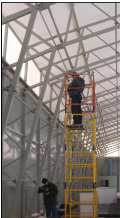
Рисунок 2.20. Обследование стального каркаса с вышки-туры
