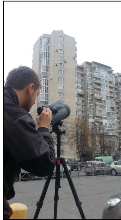
Рисунок 2.25. Обследование фасада при помощи зрительной трубы
