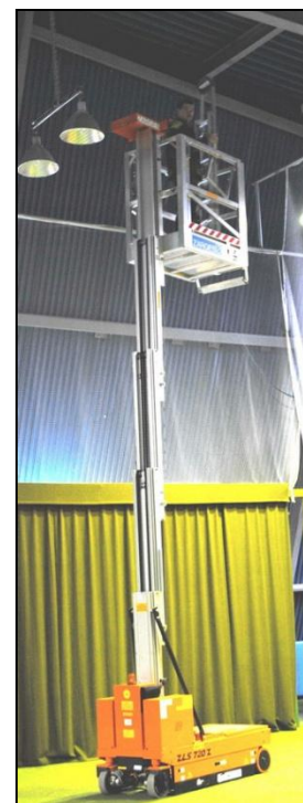
Рисунок 2.22. Исследование конструкций покрытия с телескопического электроподъемника
