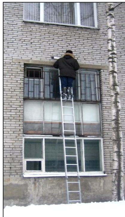
Рисунок 2.19. Обследование конструкций фасада с лестницы
