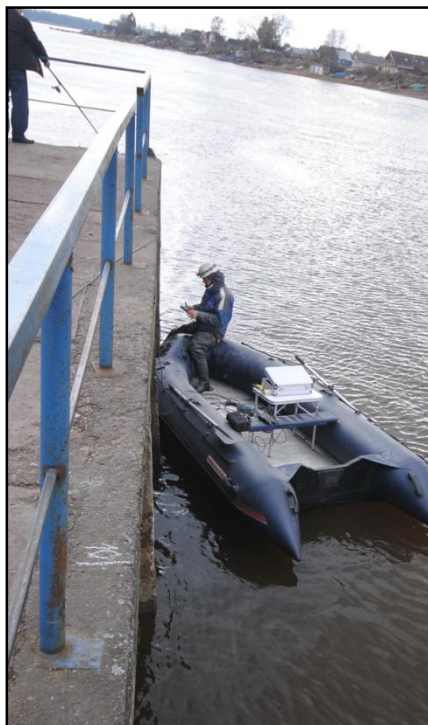
Рисунок 2.26. Обследование конструкций причала с лодки
