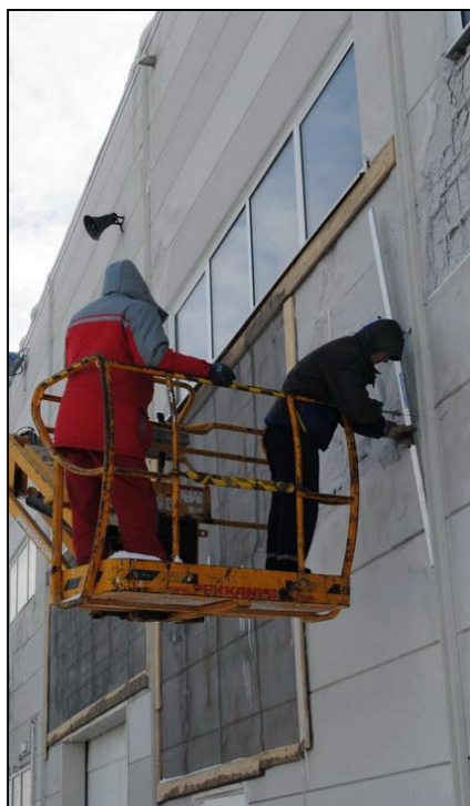
Рисунок 2.21. Измерение глубины разрушения панелей со стрелового подъемника
