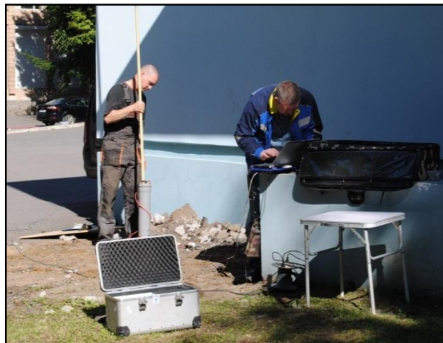
Рисунок 3.10. Исследование фундамента георадаром ОКО-2 со скважинной антенной
