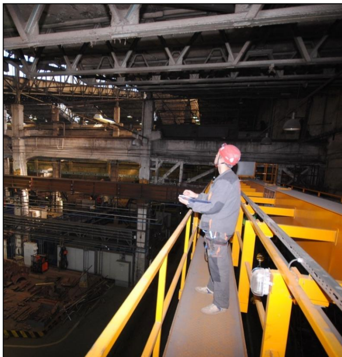
Рисунок 2.18. Обследование конструкций покрытия с мостового крана
