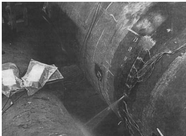
Образование течи в процессе испытаний
