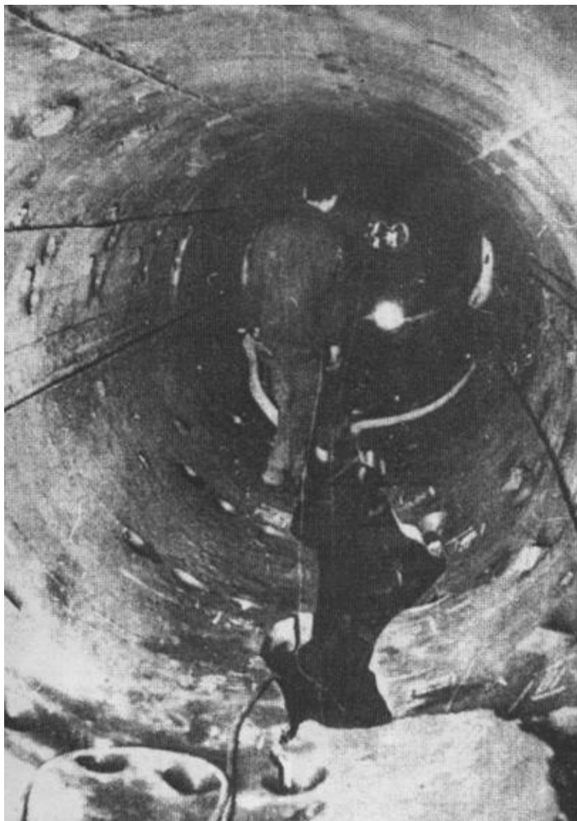
Рис. 5.18. Пример испытаний до разрушения натурального барабана котла ТП–80, отработавшего проектный срок службы
