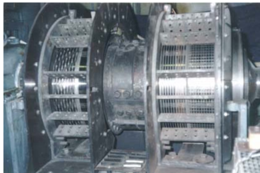
Рис.4. Полномасштабная физическая модель узла контактных колец системы токо-съемы турбогенератора мощностью 500 МВт.
