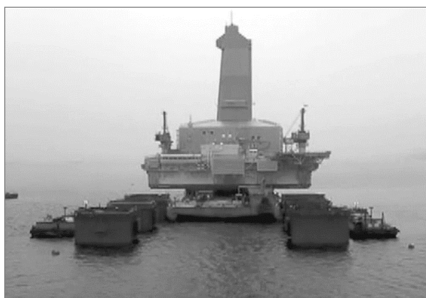
Рис. 3. Заход саморазгружающегося большегрузного транспортного судна с расположенным на нем верхним строением в пространство между колоннами опорного основания для подготовки к фазе стыковки
