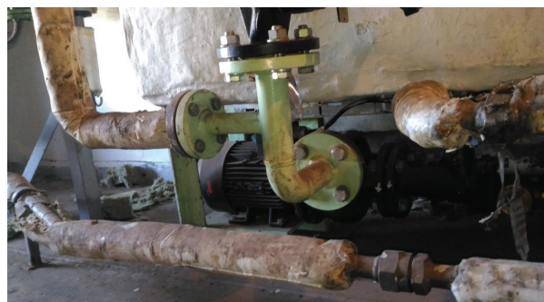
Рис. 2. Обвязка цистерны подготовки шлама
