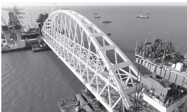
Рис. 8. Подъем арки Крымского моста, 2017 г.
