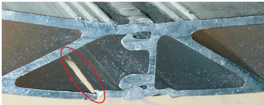
**Рис. 10.** Типовое разрушение панелей
