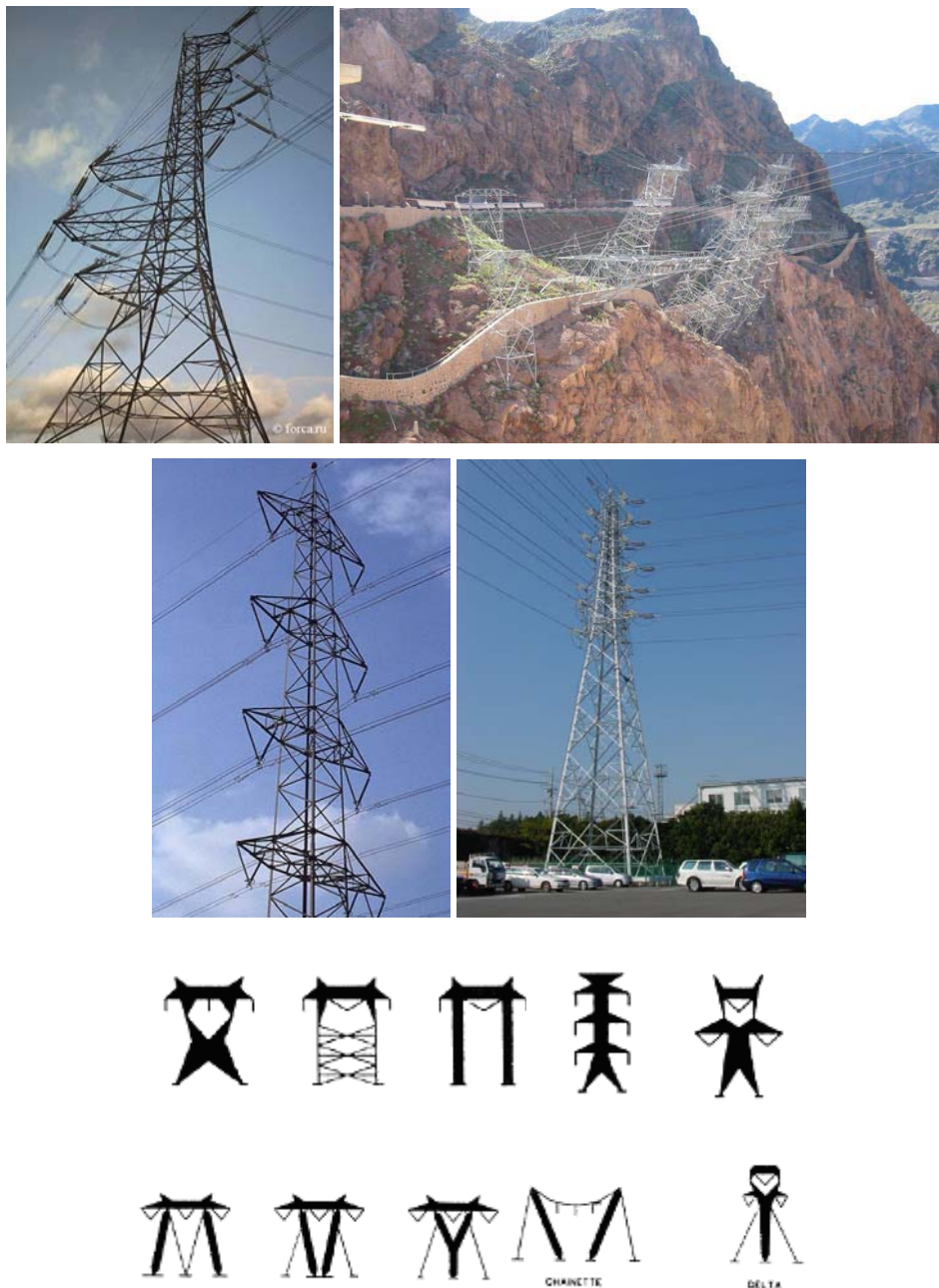
Рисунок 1. Опоры, устанавливаемые в сложных горных и городских условиях, опоры с индивидуальными конструктивными решениями
