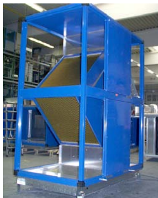
Рис. 9. Пластинчатый теплоутилизатор
