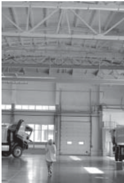
Фибробетонные полы на объединении «Пеноплэкс» (г. Кириши)
