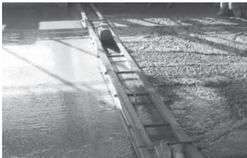
Классический способ укладки сталефибробетона при помощи виброрейки
