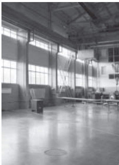
Образец реконструкции полов при помощи сталефибробетона на заводе «Яровит-Моторс» (Санкт-Петербург)
