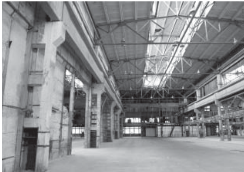
Фибробетонные полы на объединении «Пеноплэкс» (г. Кириши)
