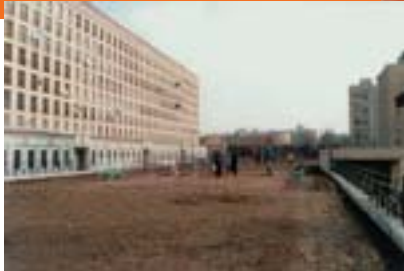
Подземный гараж, ул. Нахимова, 10, Санкт-Петербург
