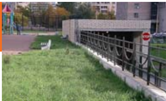
Подземный гараж, ул. Нахимова, 10, Санкт-Петербург
