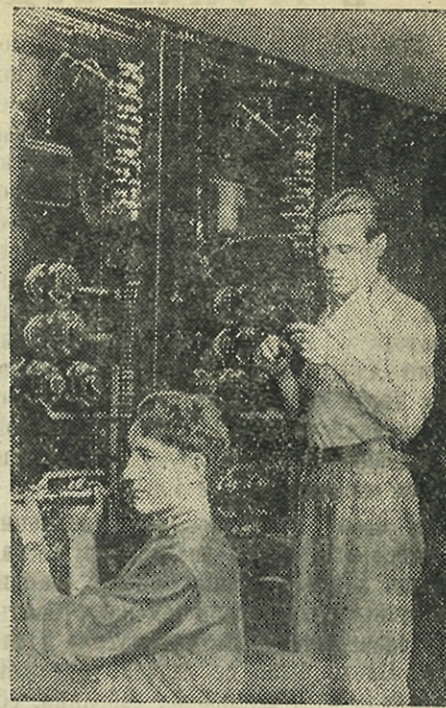
Завод «Электропульт»—одно из новых предприятий Ленинграда—выпускает щиты управления, командно-сигнальную аппаратуру и измерительные приборы для многих коопераций Советского Союза. На снимке: монтаж щита для «Чирчик-строга»
