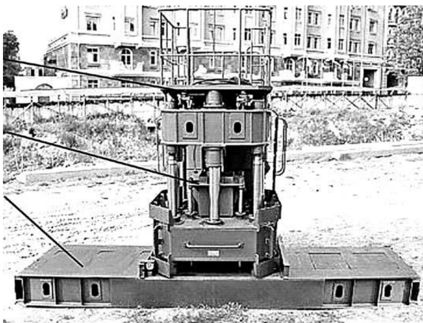
Рисунок 3.22. Установка вдавливания свай СО 450
