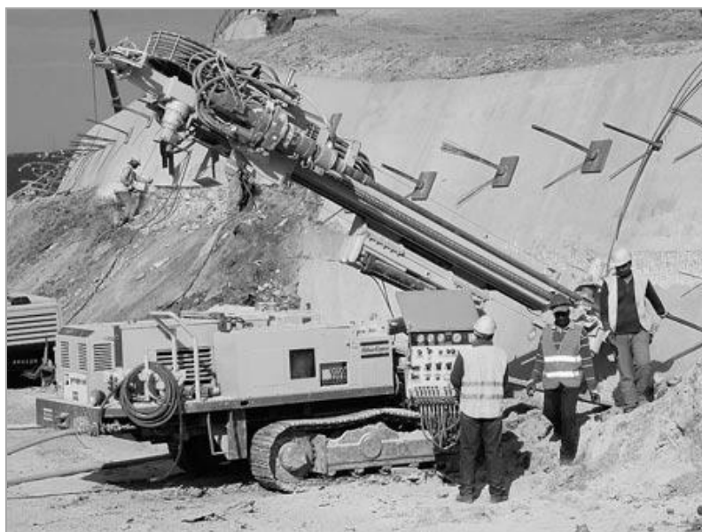
Рис. 4.7. Передвижная установка на гусеничном ходу для устройства буроинъекционных свай «ATLAS»
