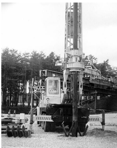
Рис. 4.4. Буровая установка МБНА-1 на базе автомобильного крана КС 4561
