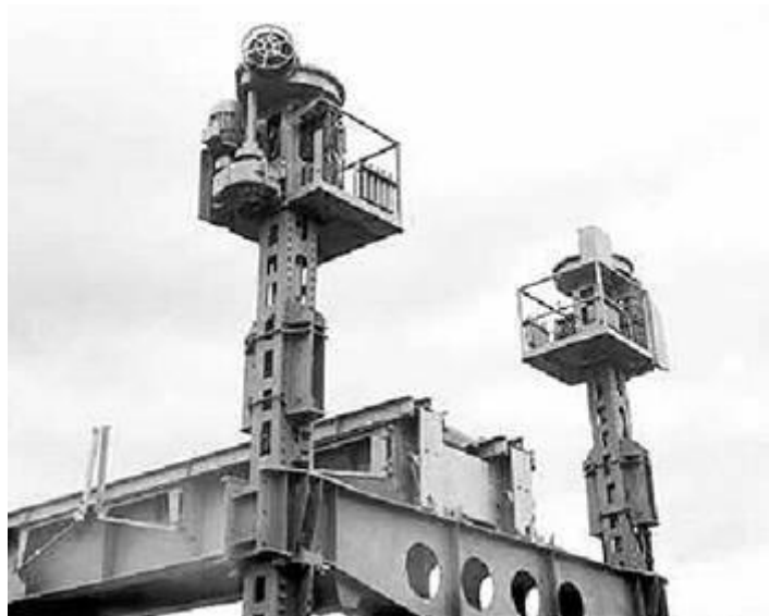
Рис. 3.24. Установка для завинчивания свай УЗС-10
